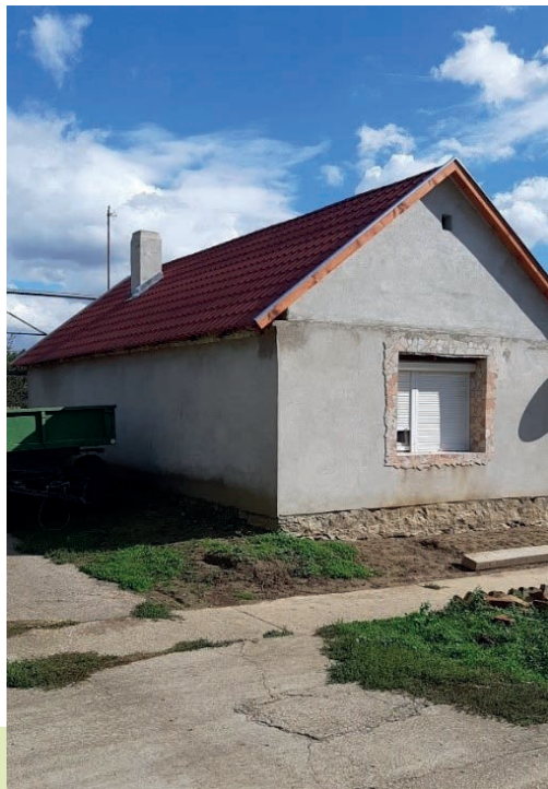
Kritikus állapotú települési lakóingatlanok felújítása
